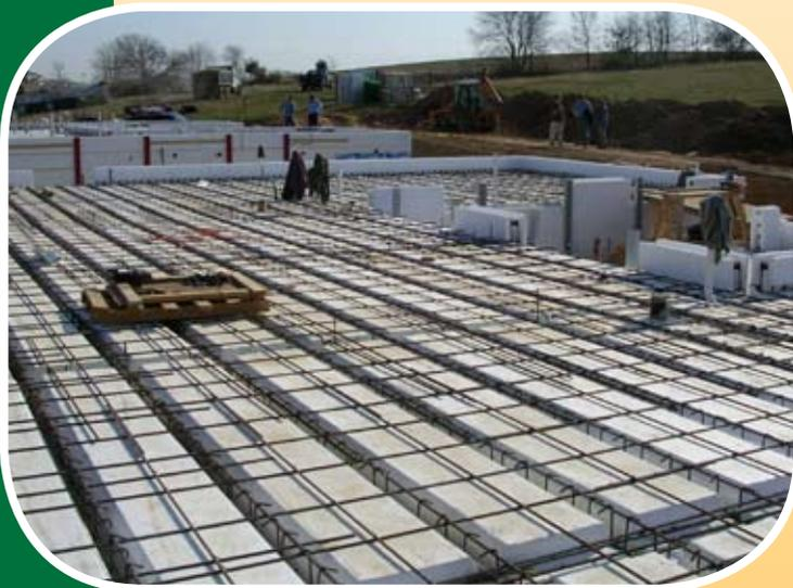
Jedes der aus expandiertem Polystyren (EPS) hergestellten Deckenmodule wird in Längsrichtung von zwei Stahlprofilen durchzogen. Quad-Deck bildet so ein selbsttragendes Formsystm, welches den Beton aufnimmt und der Decke ihre Balkenform gibt. Sie erhalten die Stärke einer Stahlbetondecke bei erheblich vermindertem Materialeinsatz und reduziertem Arbeitsaufwand. Rufen Sie uns an und erfahren Sie mehr über die Einsatzmöglichkeiten von Quad-Deck.
