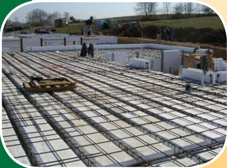
Cada uno de los paneles (EPS) de Poliestireno expandido, están soportados y reforzados con dos vigas integrales de acero moldeadas dentro del producto desde un lado hasta el otro. El resultado es una vigueta auto soportante y sistema de formación de plataforma que provee la fuerza máxima de una plataforma reforzada con un mínimo de materiales y mano de obra. Contáctenos acerca de utilizar Quad-Deck para su próximo proyecto.
