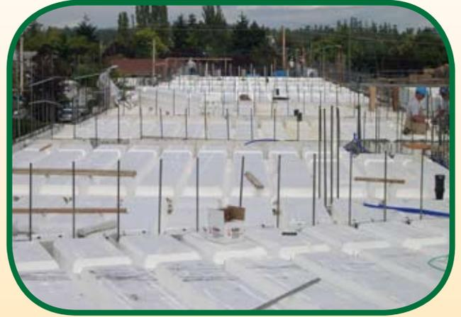
Quad-Deck utiliza Tecnología Plastbau® para crear un sistema de piso y techo con calidad aislante y eficiencia en energía.
